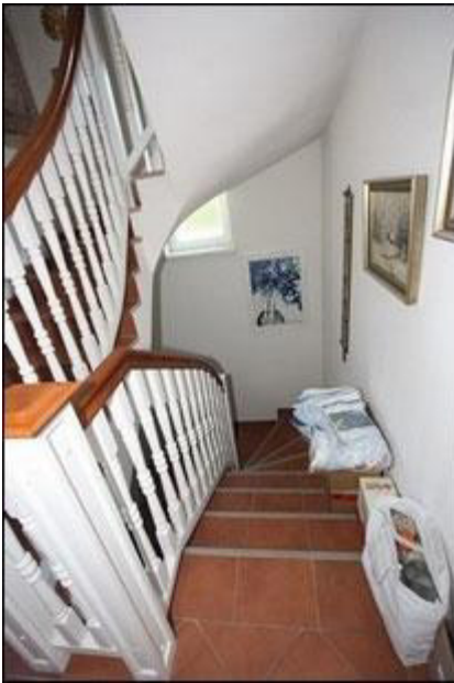
Abb.39 Ansicht Stiegenhaus EG/KG
