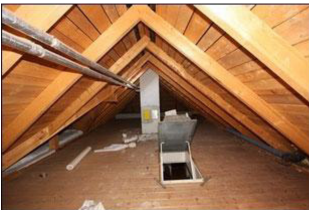
Abb.37 Ansicht Spitzboden (über Patentreppe erreichbar)
