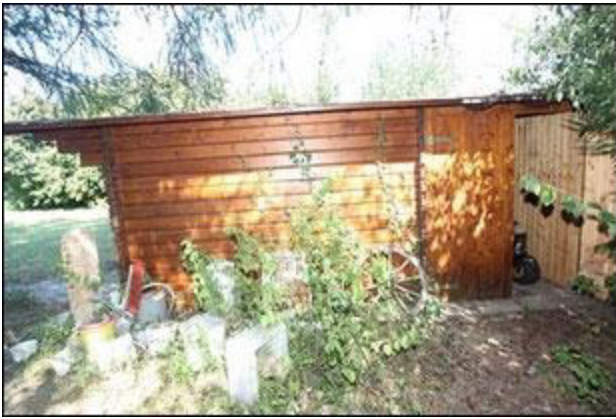
Abb.71 Ansicht Gartenhütte, Südseite
