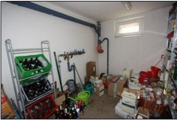
Abb.45 Ansicht Wohnhaus KG, Kellerraum
