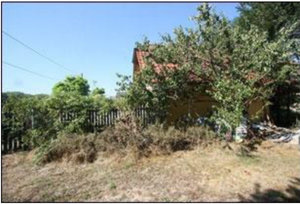
Abb.65 Ansicht Liegenschaft EZ 3265, Bauparzelle Bereich Süd, Doppelgarage
