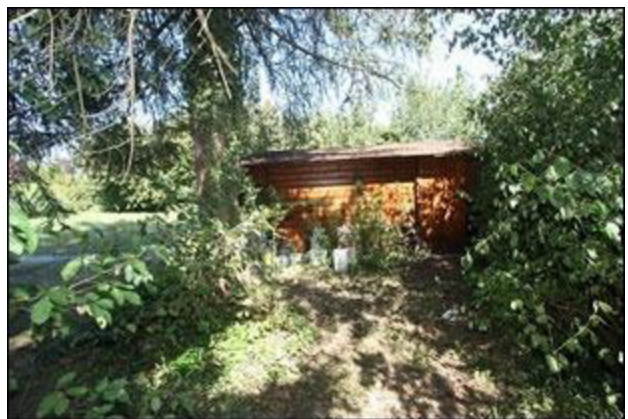
Abb.70 Ansicht Detail zu Abb.69 (Gartenhütte)
