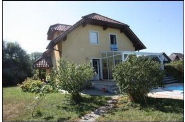
Abb.8 Ansicht Wohnhaus, Nordostseite (links Lieg. EZ 3265)
