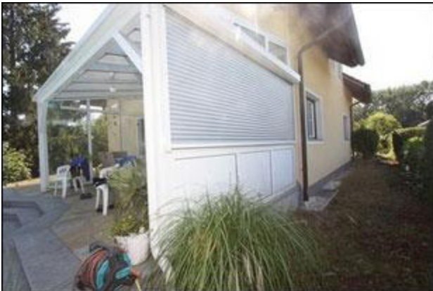
Abb.9 Ansicht Wohnhaus, Nordwestseite, Terrasse Nord mit Schutzdach
