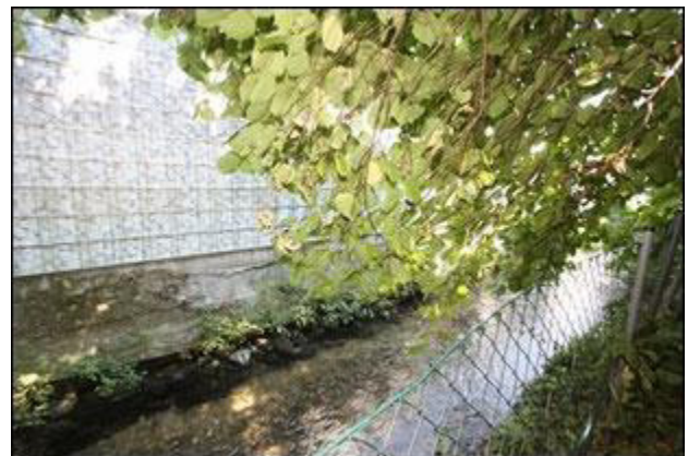
Abb.84 Ansicht Detail zu Abb.83, Bach (Magerbach) Einzäunung (Maschendraht)
