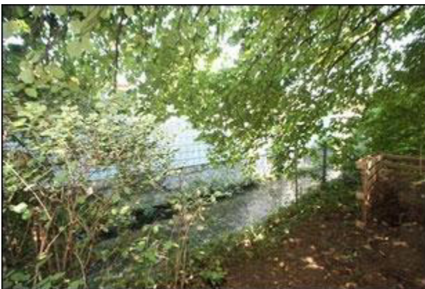
Abb.83 Ansicht Liegenschaft EZ 3265, Bereich Nord entlang Bach (Magerbach), Einzäunung (Maschendraht)
