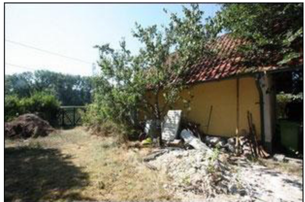
Abb.62 Ansicht Liegenschaft EZ 3265, Bauparzelle Bereich Süd, Doppelgarage
