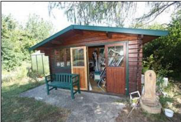
Abb.73 Ansicht Gartenhütte, Westseite
