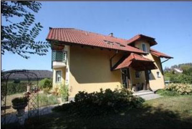
Abb.7 Ansicht Wohnhaus, Ostseite (davor Liegenschaft EZ 3265)
