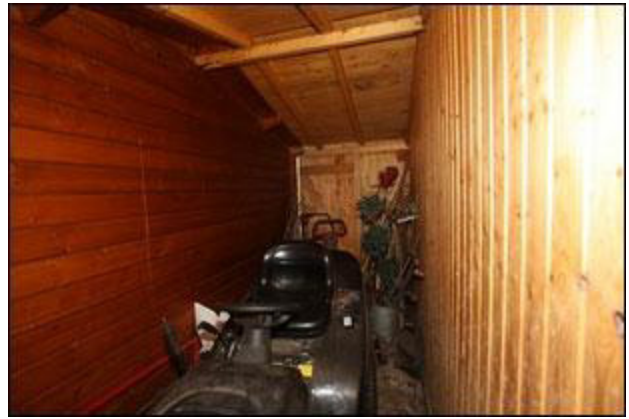
Abb.72 Ansicht Gartenhütte (Teilabschnitt Ost, Geräteraum)
