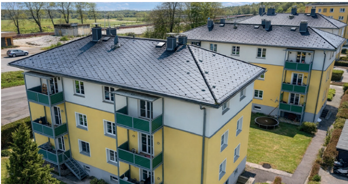
Eberschwangerstraße 11, 13, 15 Wohnungen von 53 - 121 m 2
