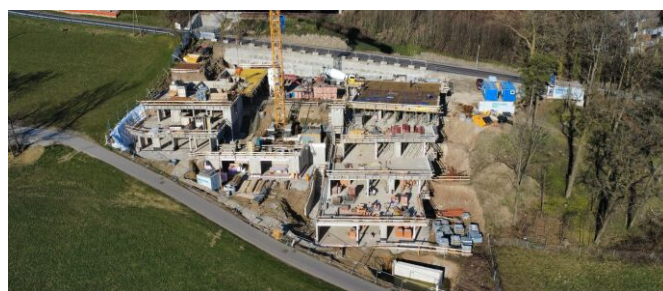
Baufortschritt Mitte März 2025
