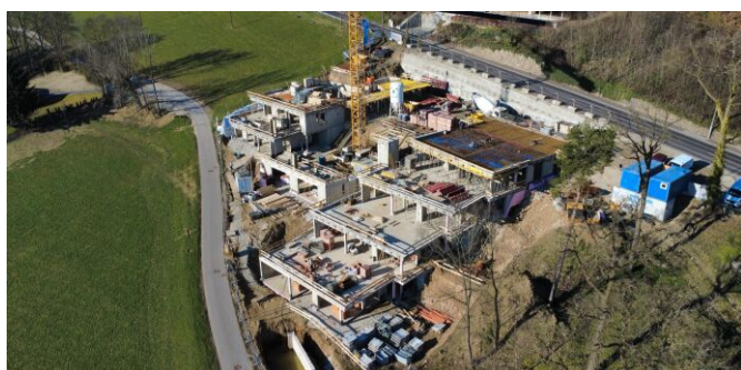
Baufortschritt Mitte März 2025
