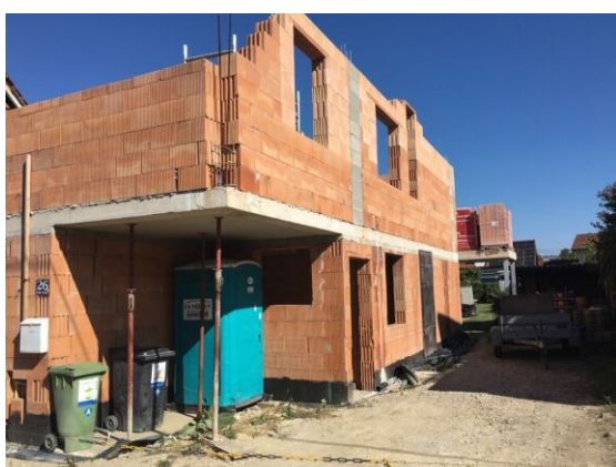
Baufortschritt - Rohbau wird demnächst fertig!
