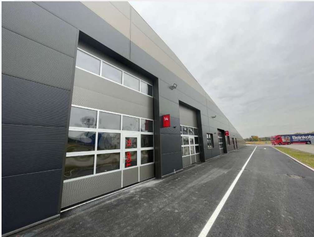
Außenansicht Halle Top 14
