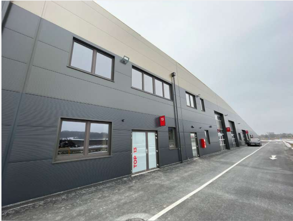
Außenansicht Halle Top 13
