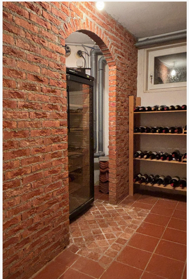
WEINKELLER UND HEIZRAUM
